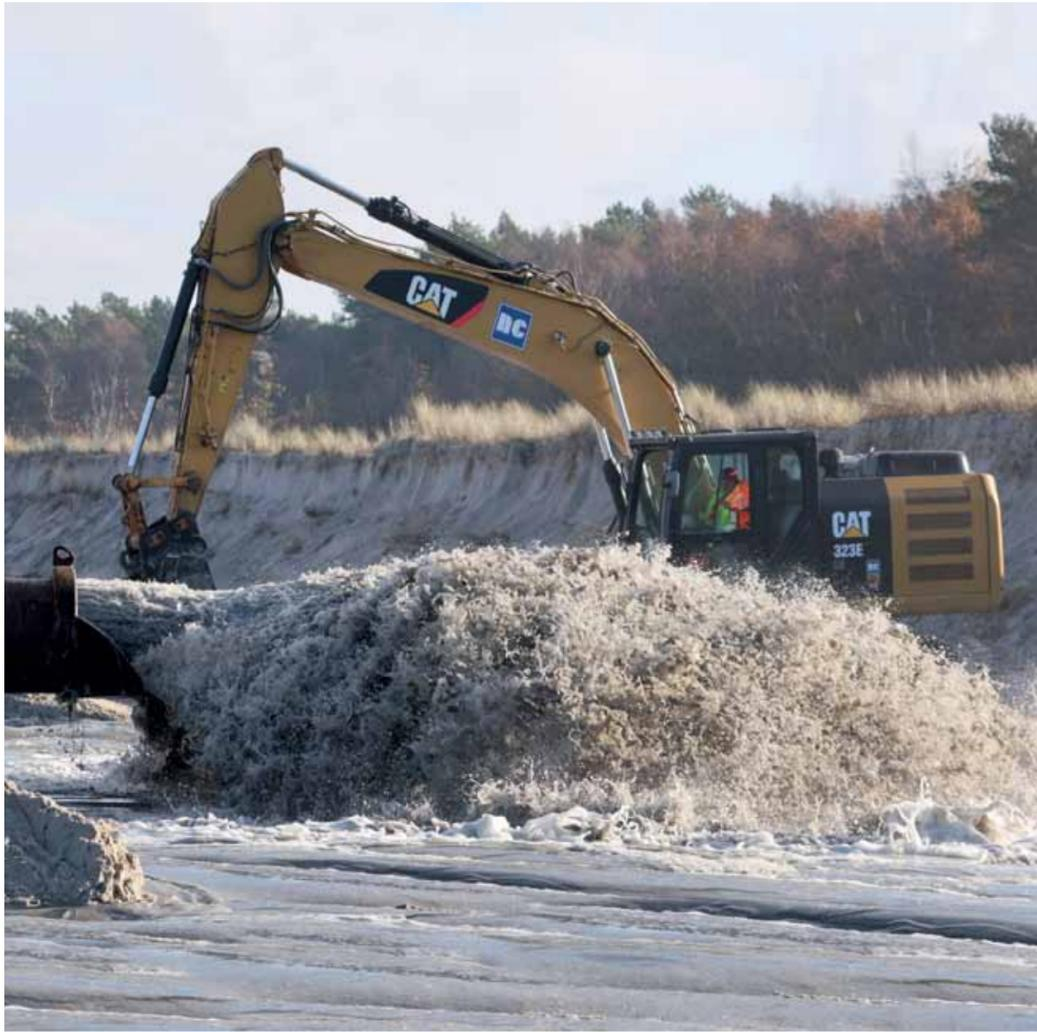
Vor dem durch die letzte Sturmflut beschädigten Deich schießt das Wasser-Sand-Gemisch für die Sandaufspülung aus einem Rohr, ein Kettenbagger steht bereit. Auf einer Länge von fast neun Kilometern werden seit Mitte Oktober der Strand und die Düne mit 720 000 Kubikmetern Sand verstärkt. Das zehn Millionen Euro teure Projekt soll Ende März 2024 abgeschlossen sein.
