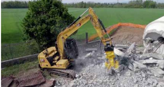
Die 1,6 Tonnen schwere Abbruchzange wurde an einem 13-Tonnen-Bagger, ein Cat 313 der neuesten Generation, montiert.
