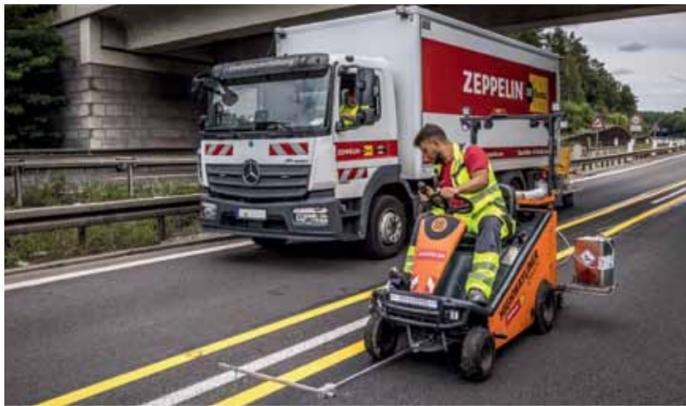
Auf der A111 kam ein „Highwayliner“ zum Einsatz, der ein präzises Anbringen der temporären Fahrbahnmarkierung ermöglicht.
