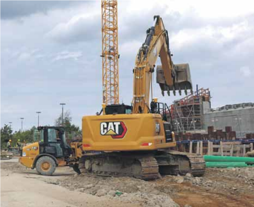
Für die Erdarbeiten kommen knapp 50 Cat Baumaschinen zum Einsatz.
