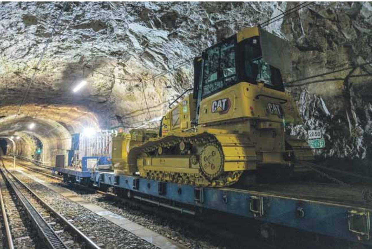
Präzise vorbereitet für den Spezialtransport: Der Cat Kettendozer D4 wird mit der Zahnradbahn zum Zugspitzplatt transportiert.
