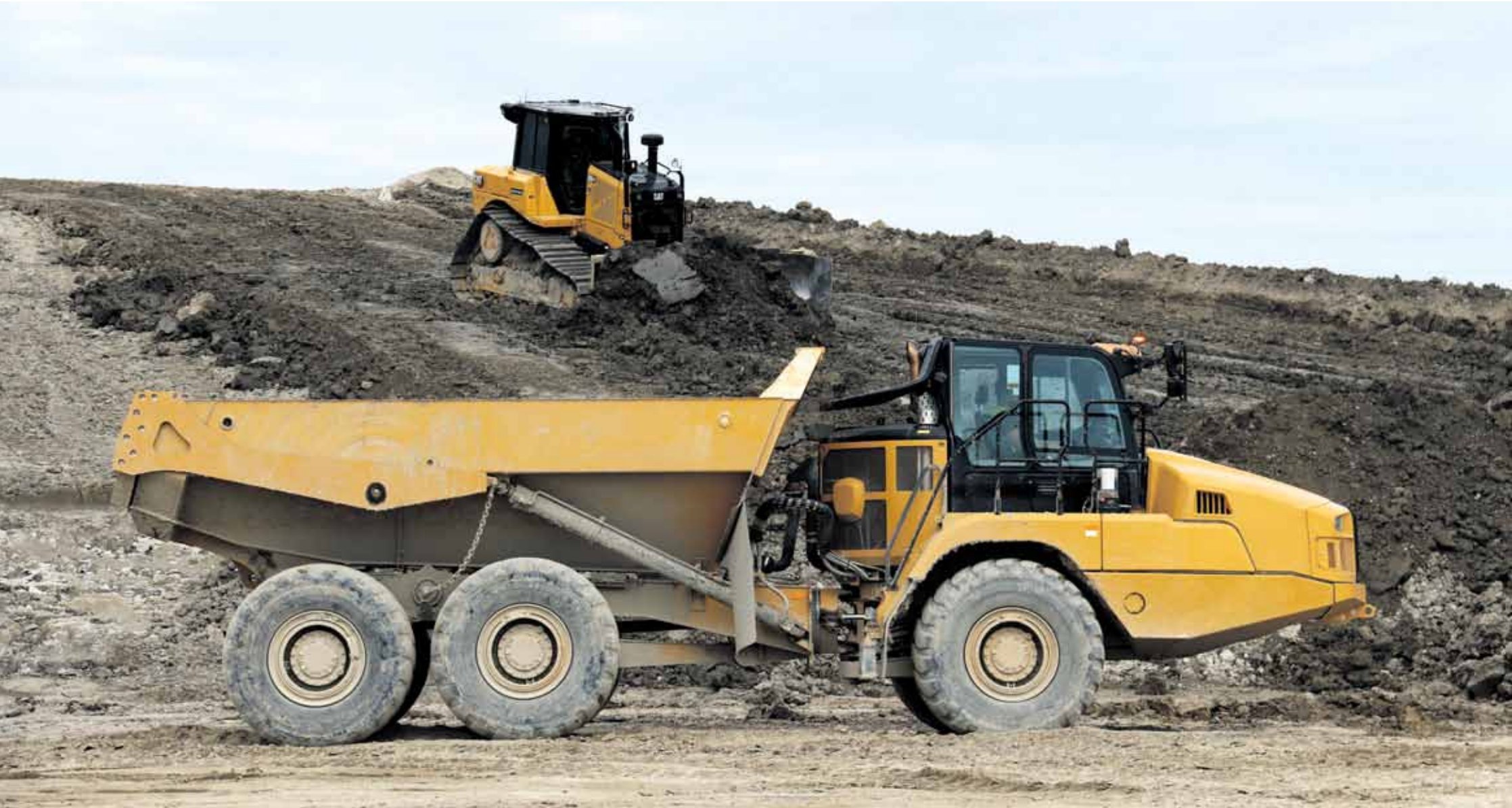
Mit der Entwicklung der Großbaustelle steigen auch die Anforderungen an die Logistik kontinuierlich.
