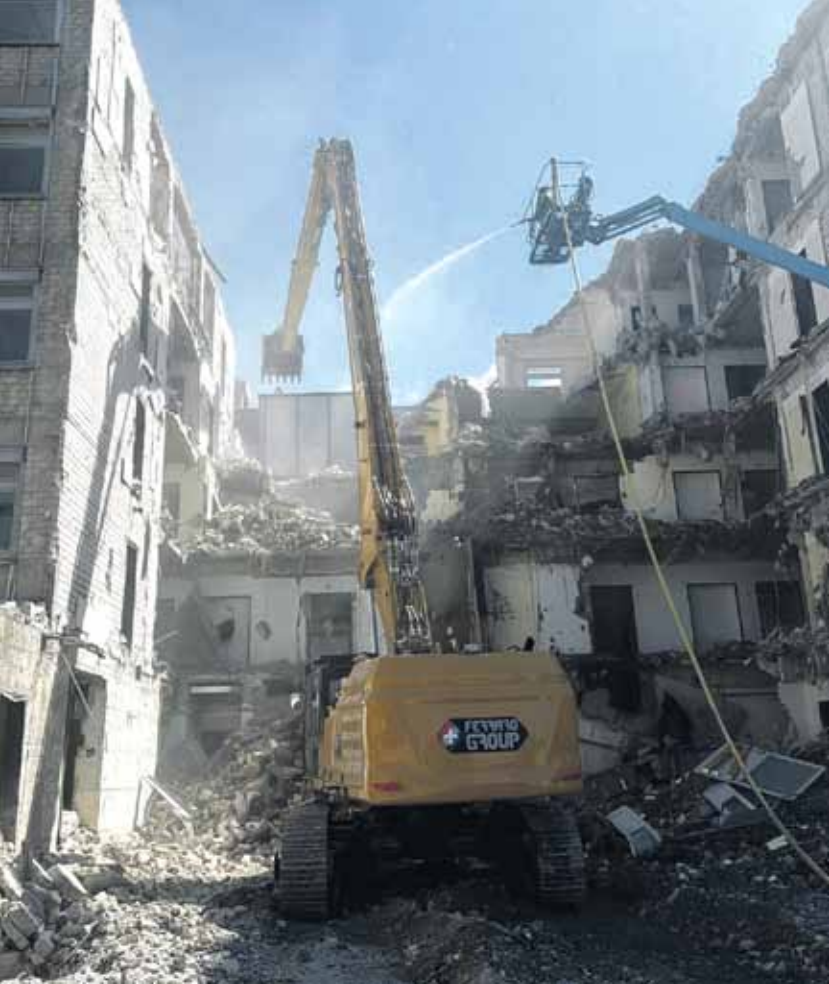
Schwere Kettenbagger mit UHD-Ausleger sind Schlüsselgeräte im Rückbau und bei Industriedemontagen. Fotos: Zeppelin
