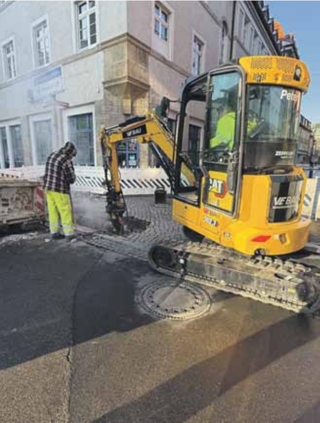
Rohrleitungs-, Kabel- und Tiefbau werden weiterentwickelt.
