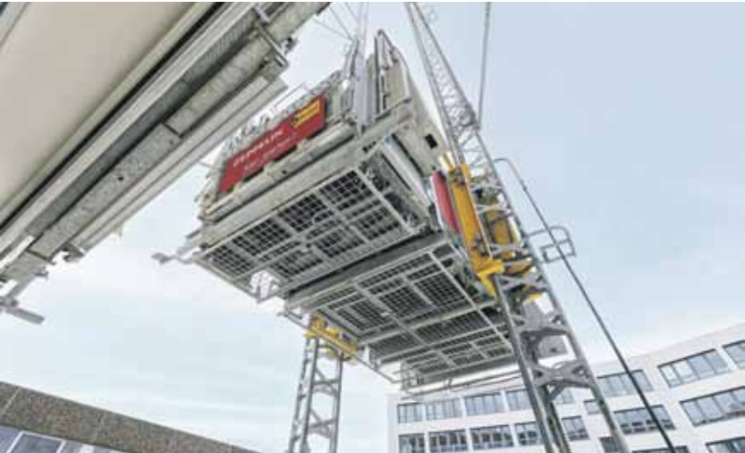
Ein GEDA-Aufzug bringt das Rückbaumaterial ins Erdgeschoss.
