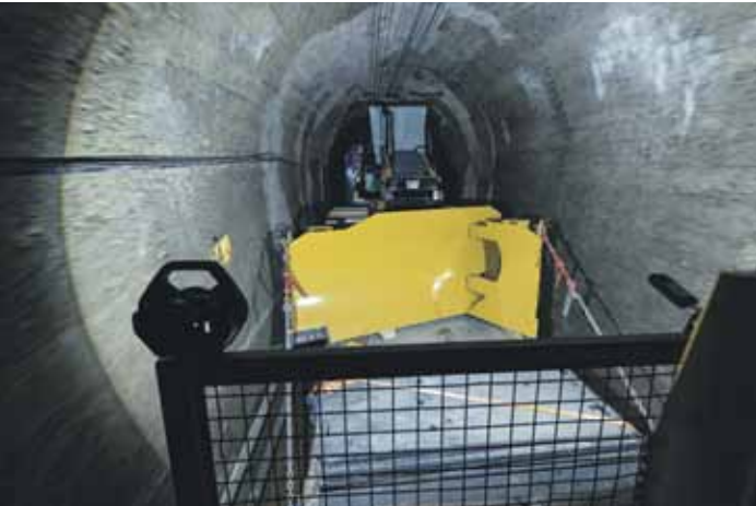
Jeder Zentimeter zählt: Die beengten Platzverhältnisse im 4,5 Kilometer langen Felstunnel lassen keine Maßüberschreitungen zu.
