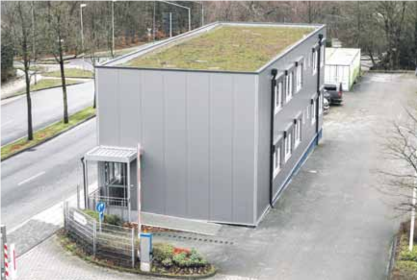
Das Gründach bietet neben ökologischen Vorteilen auch bauphysikalische Mehrwerte. Fotos: action press/Ulrik Eichentopf
