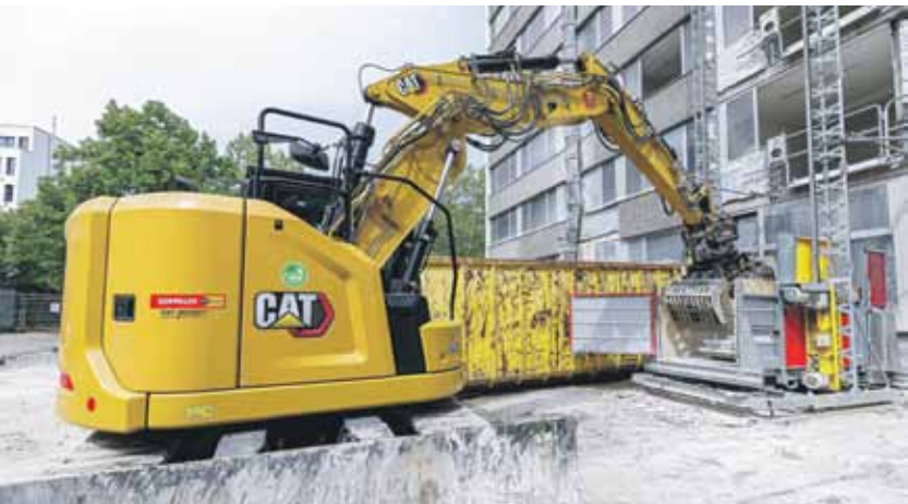
Der Sortiergreifer des Cat 315 VAH ermöglicht das präzise Greifen und Heben von Bauteilen. Fotos: action press/Ulrik Eichentopf
