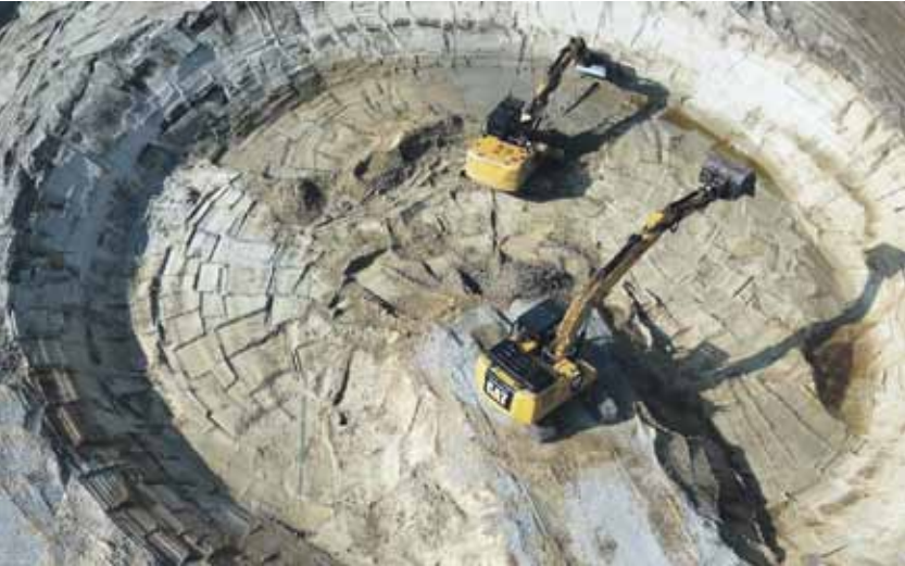
Wo früher Flächen und Massen aufwendig vor Ort ermittelt wurden, genügt heute ein Überflug mit einer Drohne. Fotos: Dreger Tiefbau
