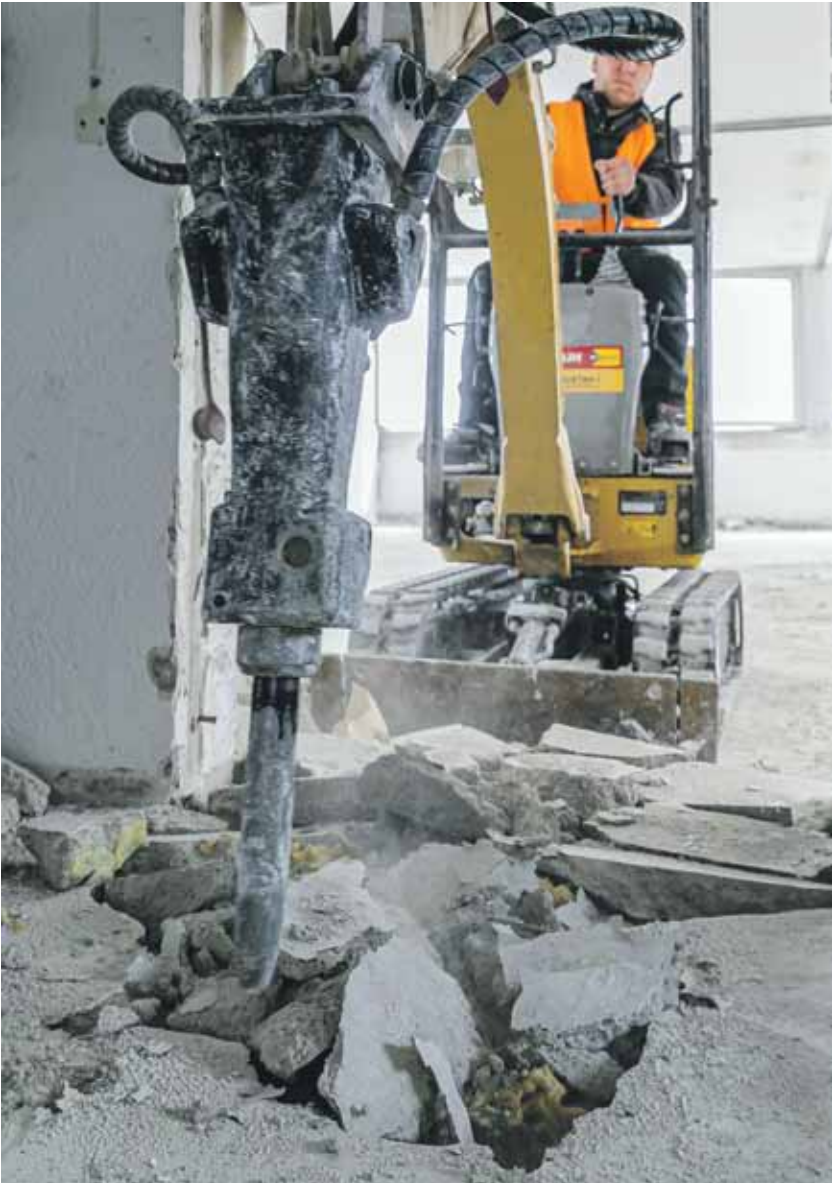
Mit dem Hydraulikhammer stemmt der Cat 300.9D Bodenbeläge und Fundamente kontrolliert auf.
