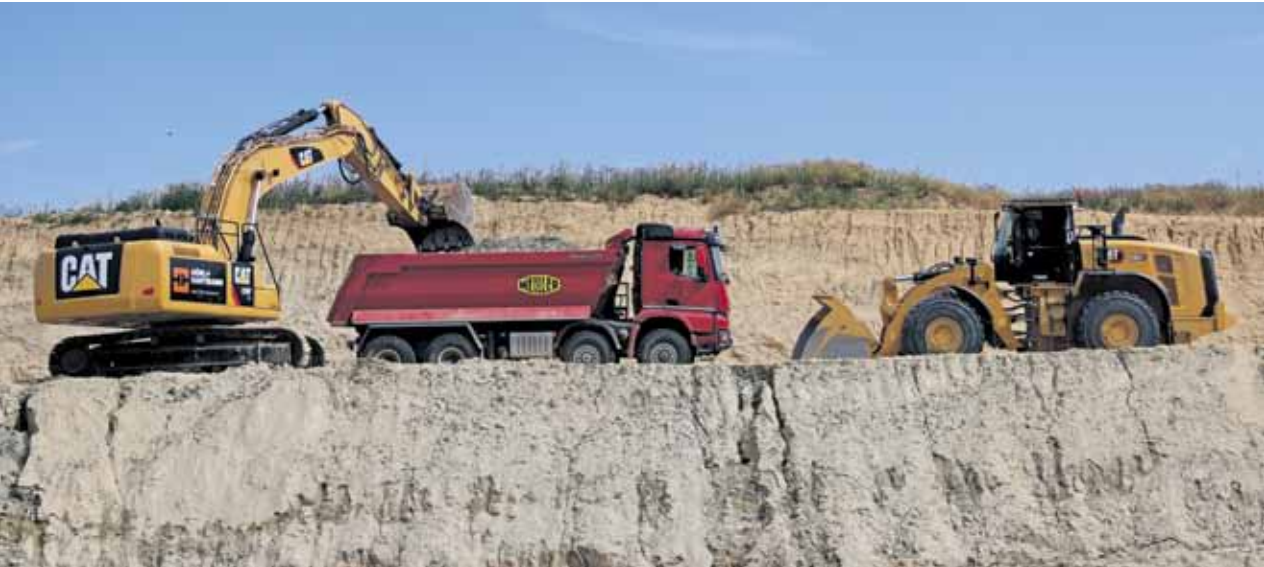
Cat Baumaschinen sorgen dafür, dass die unterschiedlichen Tonschichten exakt getrennt und der Ziegelproduktion in der gewünschten Qualität zugeführt werden.
