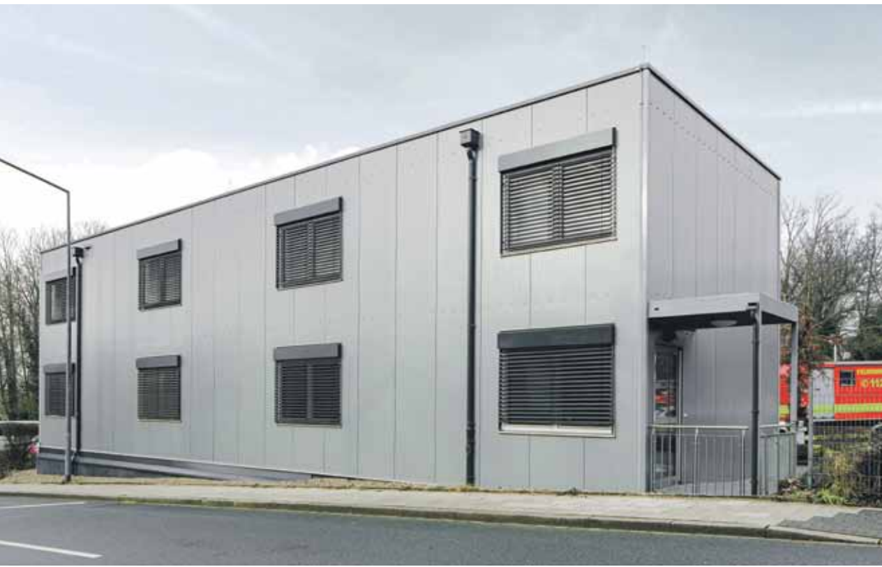
Das Bürogebäude umfasst 14 Raummodule. Eine PU-Sandwichpaneel-Fassade verleiht dem Gebäude eine moderne Optik.
