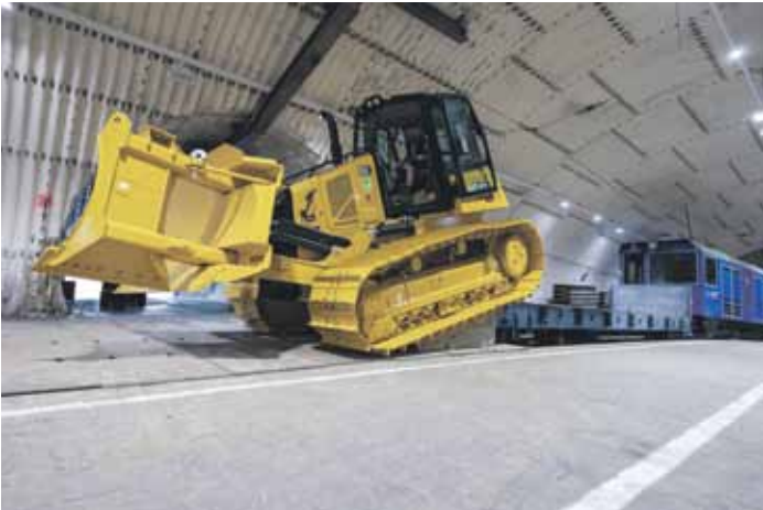
Auf rund 2 600 Metern Höhe werden die Bauteile des Kettendozers wieder fachgerecht montiert.
