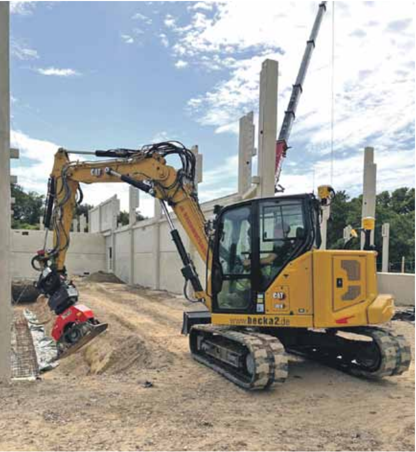
Die Becka GmbH setzt konsequent auf 3D-Maschinensteuerung – seit sieben Jahren auf Cat Kettenbaggern der 15- bis 30-Tonnen-Klasse und seit der bauma 2022 schrittweise auch auf allen Cat Minibaggern der Sechs- und Acht-Tonnen-Klasse.
