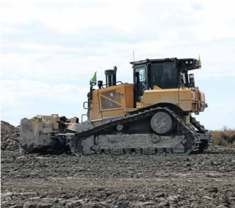
Das Abtragen und Einbauen von Material übernehmen Cat Raupen. Fotos: Zeppelin
