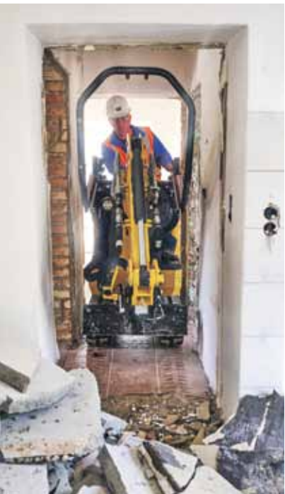
Seine kompakte Bauweise reduziert dabei den Überstand der Maschine und erleichtert Arbeiten unmittelbar neben Mauern und anderen festen Strukturen. Das Fahrwerk lässt sich von 1 100 auf 730 Millimeter Breite einziehen.
