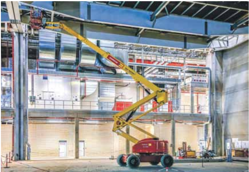
Gelenk-Teleskopbühnen ermöglichen Arbeiten in schwer zugänglichen Bereichen. Für die Servicierung der Geräte waren bis zu acht mobile Servicetechniker unterwegs. Fotos: action press/Peter Seyfferth
