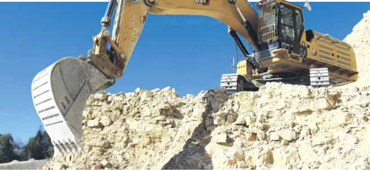
Der Cat 374 löst den feinbankigen Kalk mit einem Reißzahn und lädt das Material anschließend mit einem 4,5-Kubikmeter-Löffel auf Dumper.
