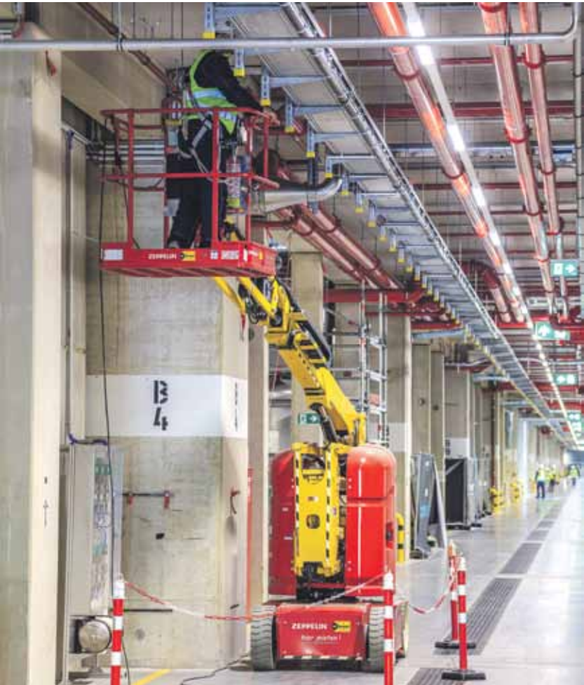
Zum Einsatz kamen ausschließlich elektrische und hybride Geräte, da ein Großteil der Arbeiten in Innenräumen stattfand.
