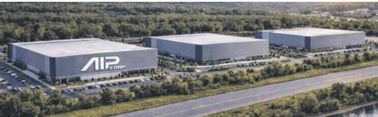
Mit dem Monarch Compute Campus entsteht in West Virginia ein mehrstufig ausgebauter Energie- und Infrastrukturstandort, der speziell auf die hohen Anforderungen von KI-Rechenzentren zugeschnitten ist.
