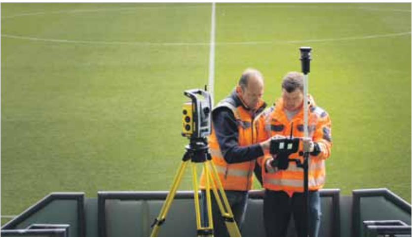
Für die Positionierung ist eine Totalstation Trimble SPS930 im Einsatz; für die Kontrollen wird ein Rover mit dem Feldrechner Trimble TSC7 verwendet. Fotos: Heiler
