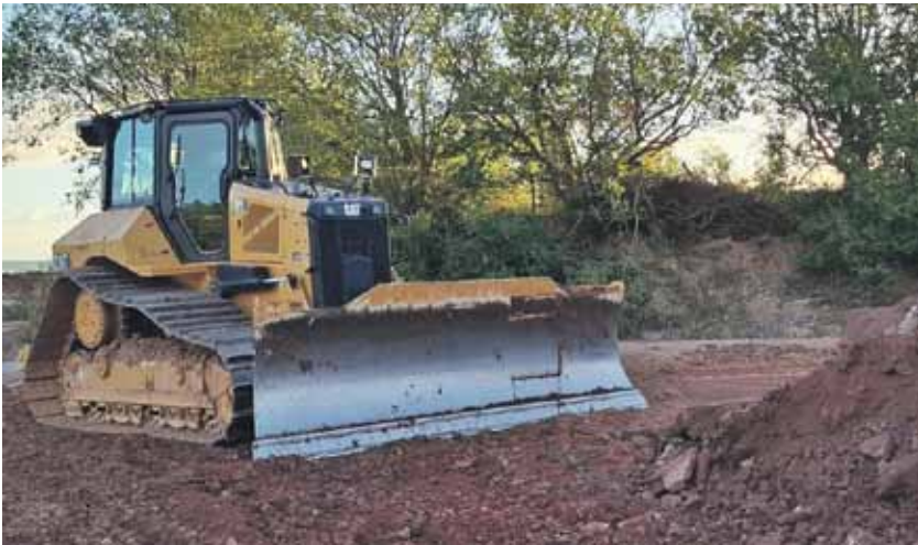
Eine Aufgabe der Raupe ist es, Bodenmassen lagenweise zu dauerhaft sicheren Halden aufzubauen.
