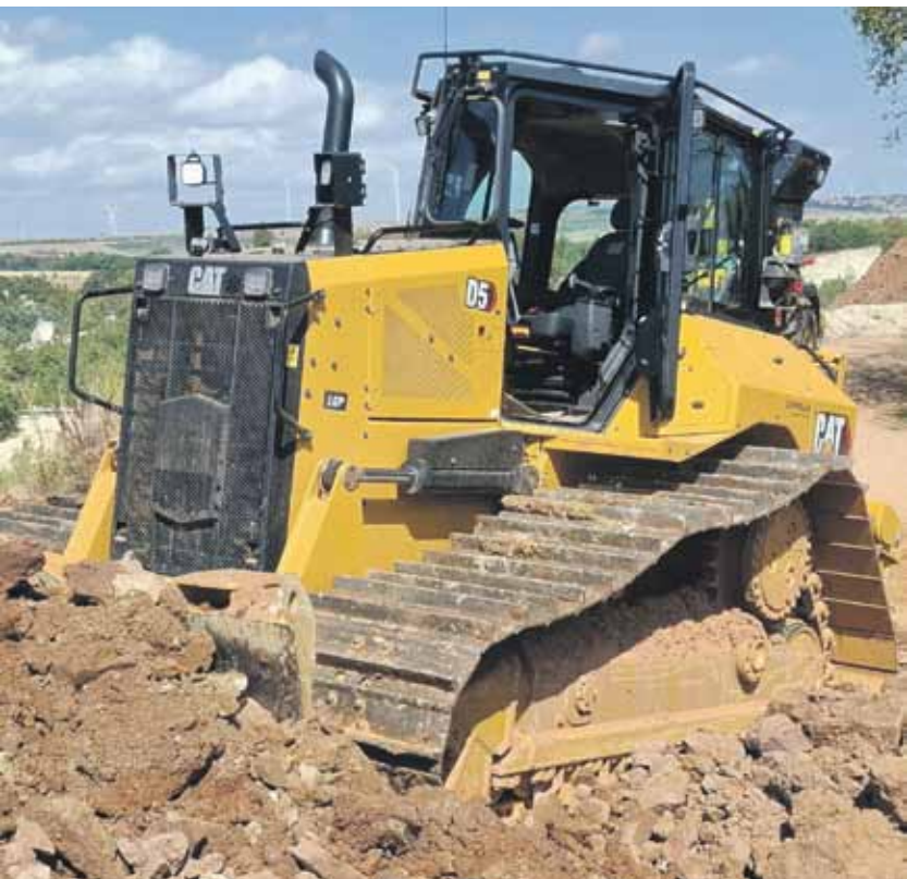
Beim Einbau soll das Material möglichst gleichmäßig überfahren und verdichtet werden.
