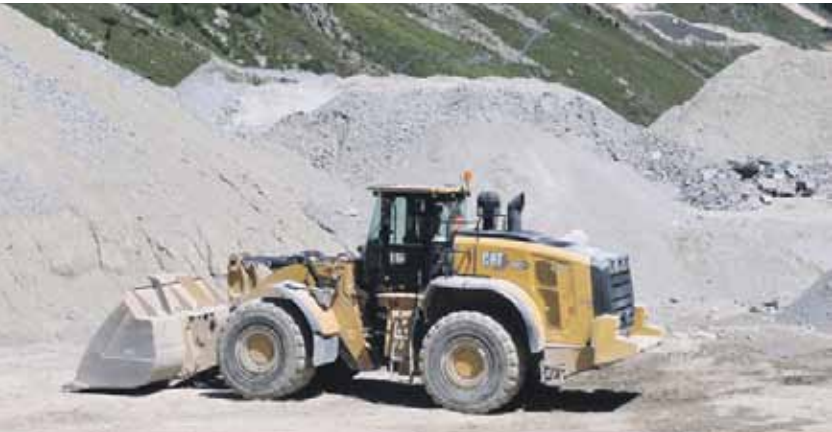
Großgeräte nahmen sich die Bauaufgabe vor.
