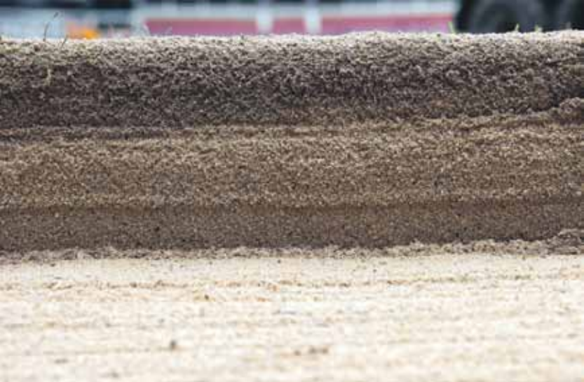
Die oberen Tragschichten werden in Millimetergenauigkeit abgefräst.
