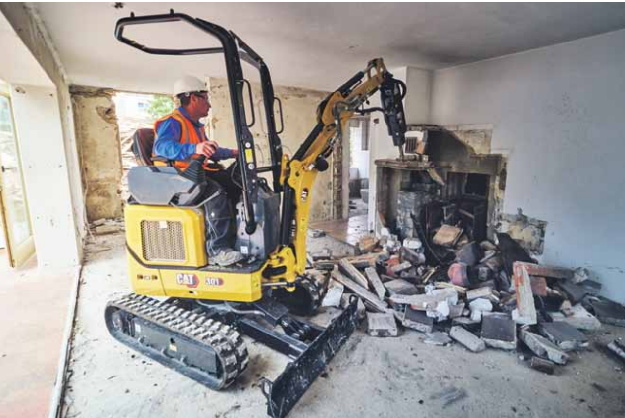
Für Abbrucharbeiten von Beton oder Asphalt kann der 301 CR mit dem Hammer ausgerüstet werden.
